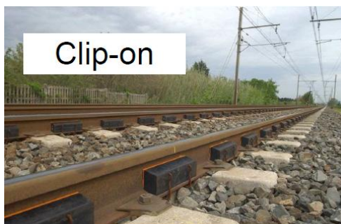
Figura nr 4: Amortizor de zgomot CORUS, aplicat
